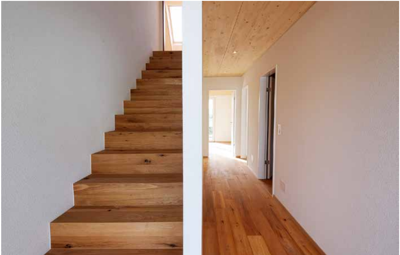
Im Innenausbau spielt das Baumaterial Holz ebenfalls die wichtigste Rolle. Die Innenwände sind mit einem mineralischen Material verputzt und mit einer Farbe auf Silikat-Kali-Wasser-Basis gestrichen.
